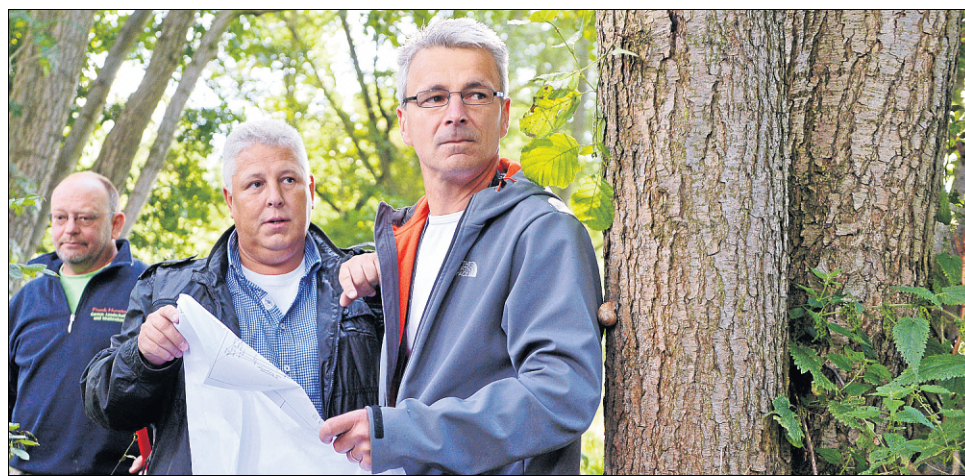
Landschaftsbauer Frank Hunstock, Bernd Kiel vom Gewässerunterhaltungszweckverband Eichsfeld und Thomas Hellwig, Grundstückseigner, beim Abstecken des neuen Bachbetts.
